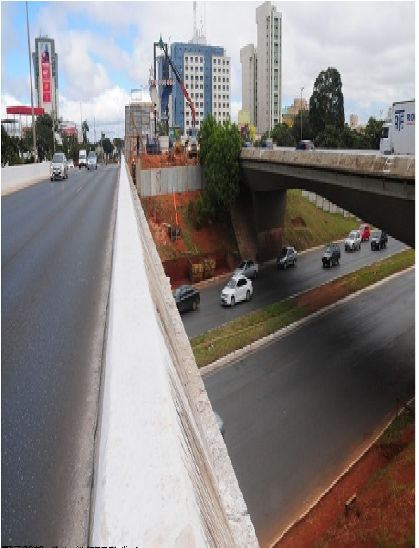
07/09/2016 - Trabalho em EPTG para a construção do viaduto para
